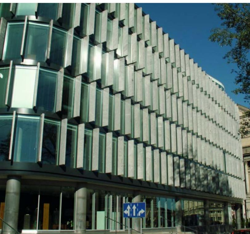
Metropolitan, Warschau, Polen: Für die sichere Befestigung der Glasfassadenelemente werden glatte und gezahnte JORDAHL® Ankerschienen eingesetzt
