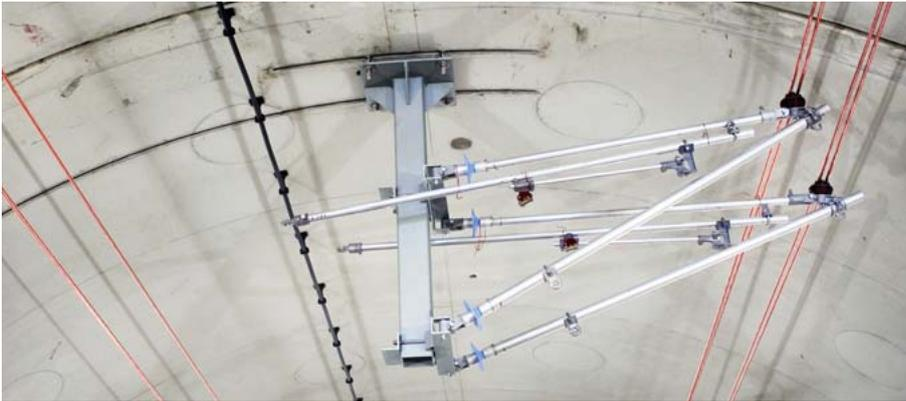
Gebogenes Ankerschienenpaar zur sicheren Befestigung von Oberleitungen in Bahntunneln
